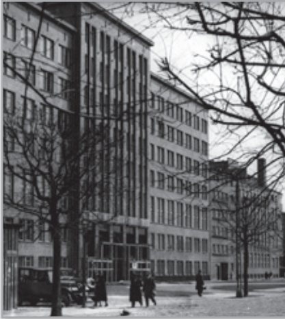
Siedziba Ministerstwa Robót Publicznych przy ulicy Chałubińskiego w Warszawie. NAC
